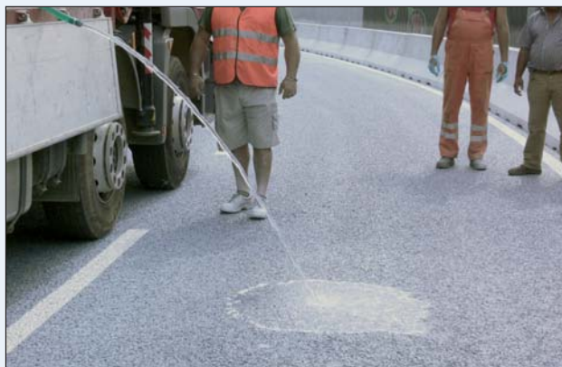
Figura 9 - La verifica di cantiere della capacità drenante
