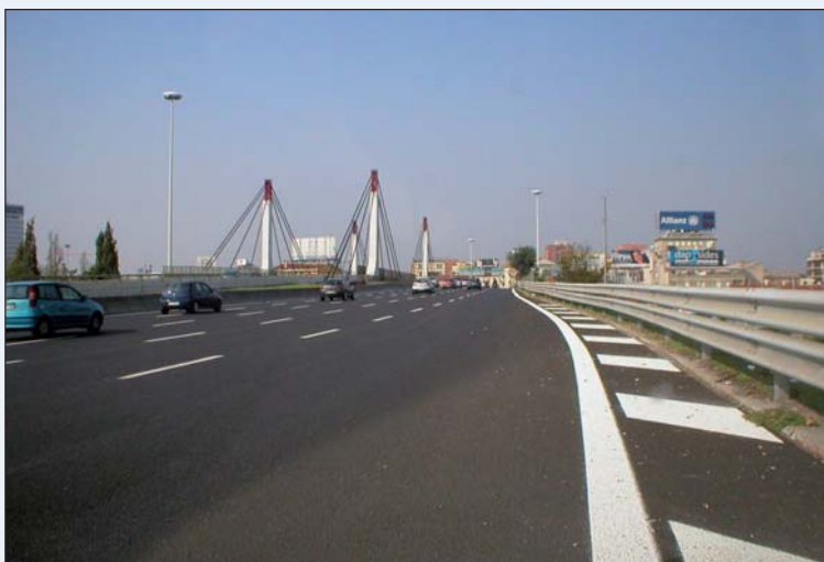
Figura 7 - L'intervento di ripavimentazione completato sul cavalcavia del Ghisallo
