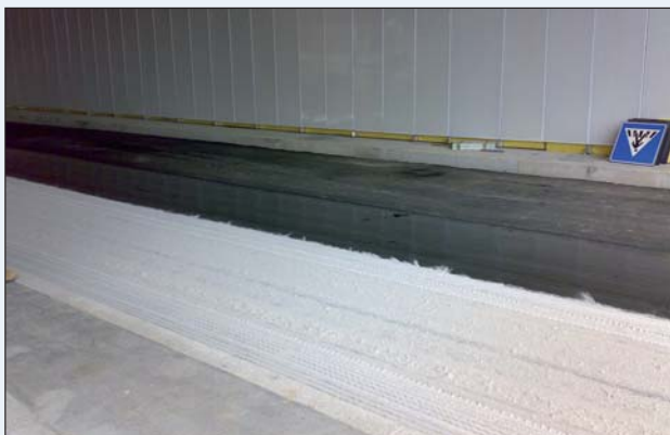
Figura 6 - La realizzazione della pavimentazione fonoassorbente nel tunnel della Via del Nord
