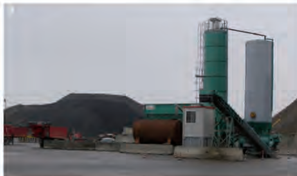
7. Il piazzale di Impresa Bacchi e l'impianto di produzione di misto cementato
