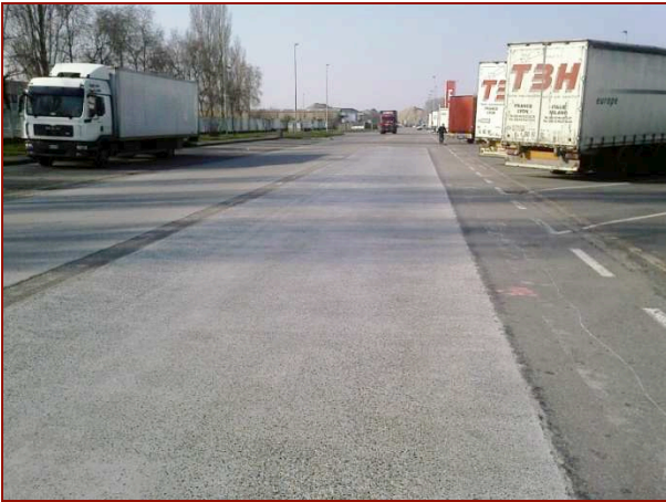
Figura 2: campo prove su una pavimentazione fotocatalitica in bitume-cemento, 2011
